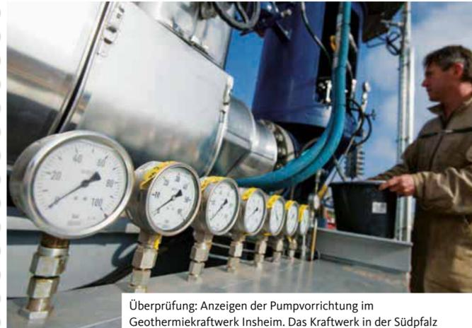
Überprüfung: Anzeigen der Pumpvorrichtung im Geothermiekraftwerk Insheim. Das Kraftwerk in der Südpfalz erzeugt bisher nur Strom, bald sollen Wärme und Lithium-Gewinnung folgen. Genutzt wird rund 160 Grad heißes Thermalwasser aus über 3.000 Meter Tiefe.
