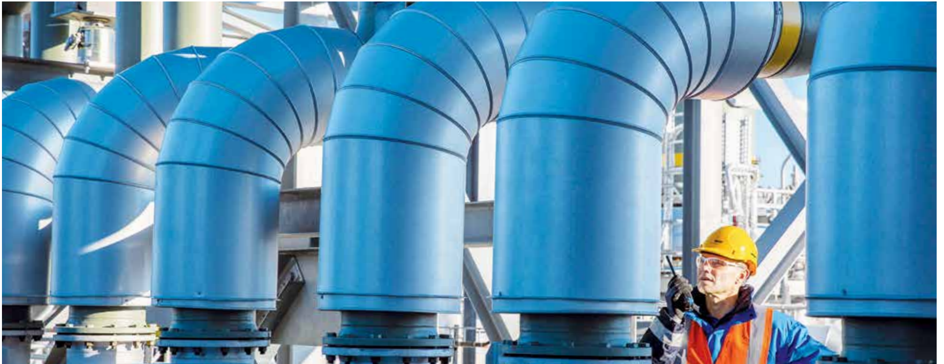
TDI-Anlage der BASF: Die Produktion des Zwischenstoffs musste wegen des Niedrigwassers im Rhein zeitweise eingestellt werden.
