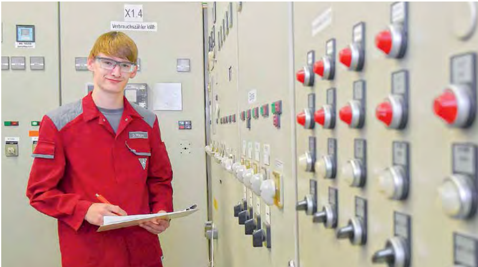
In der Messwarte: David Wagner kennt sich hier bereits aus.
